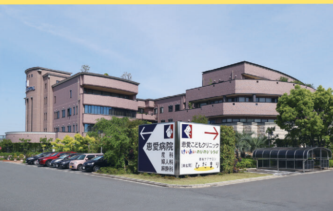
恵愛病院全景／駐車場250台
